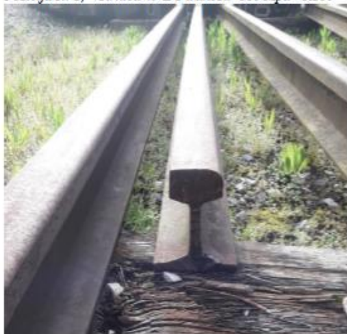
Pozicija št. 2, Tirnica 49 E1 trdnosti 880 Mpa - R260
