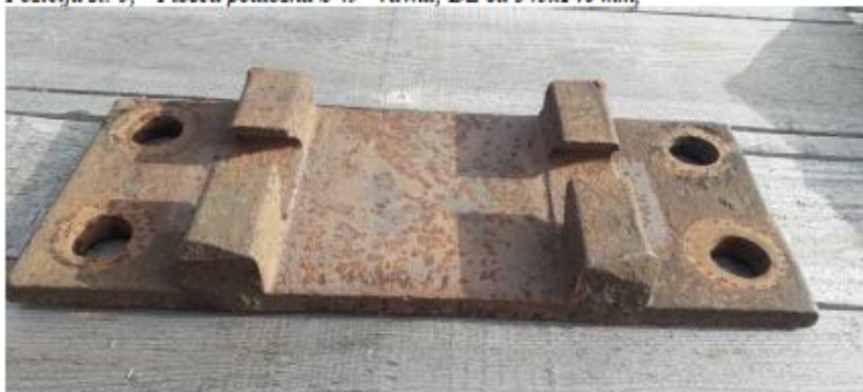
Pozicija št: 5, Plošča podložna S 49 - ravna; DŽ 6a 345x140 mm,
