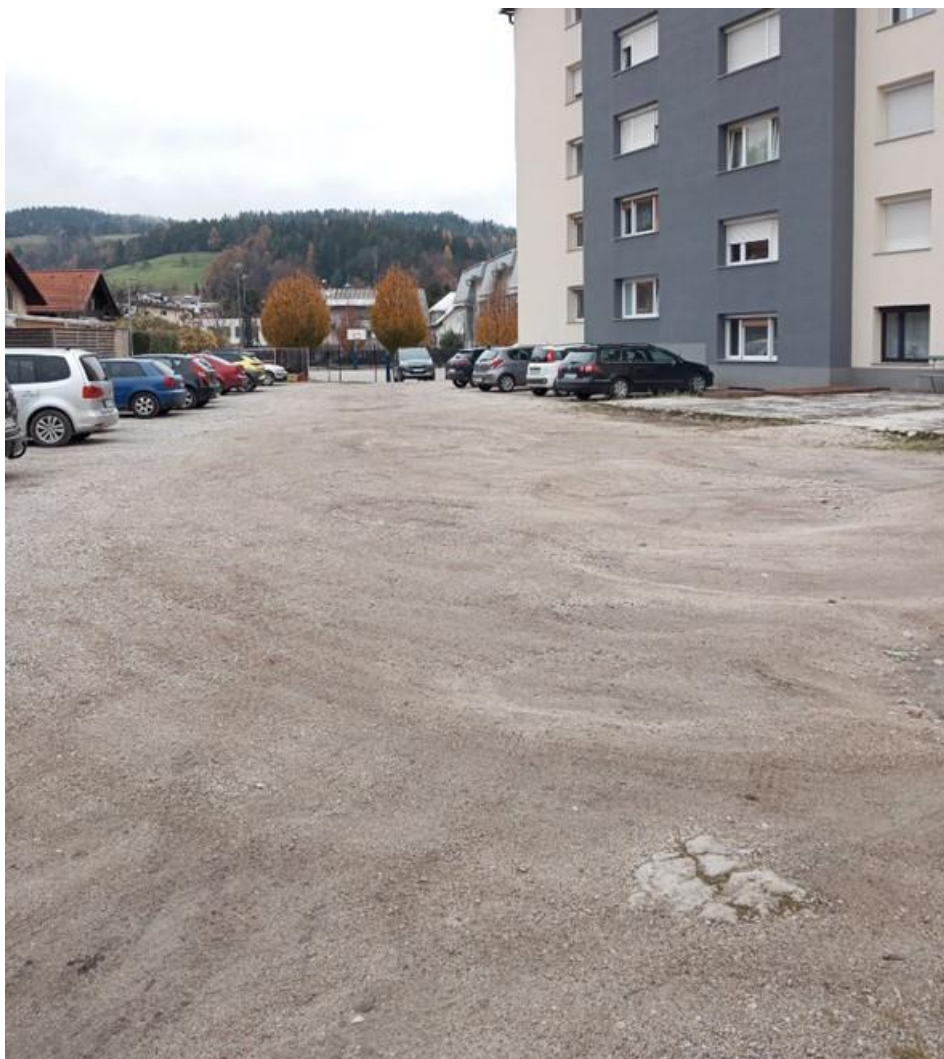
Sliki: Makadamske površine na Lenartovi
