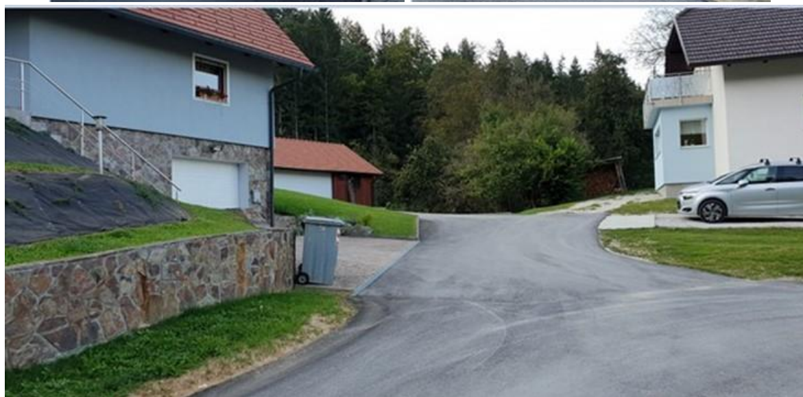
Slike: Preplastitev cestnega odsega Podkraj pri Mežici
