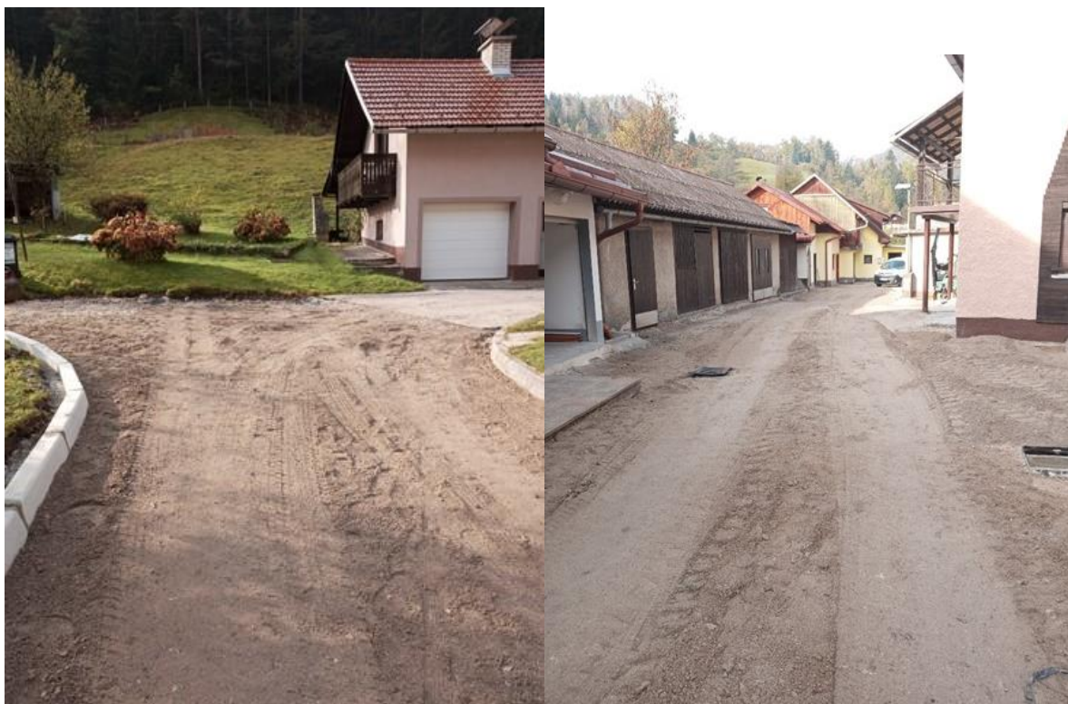
Slike: Preplastitev ceste nasproti Osnovne Šole Črna na Koroškem
