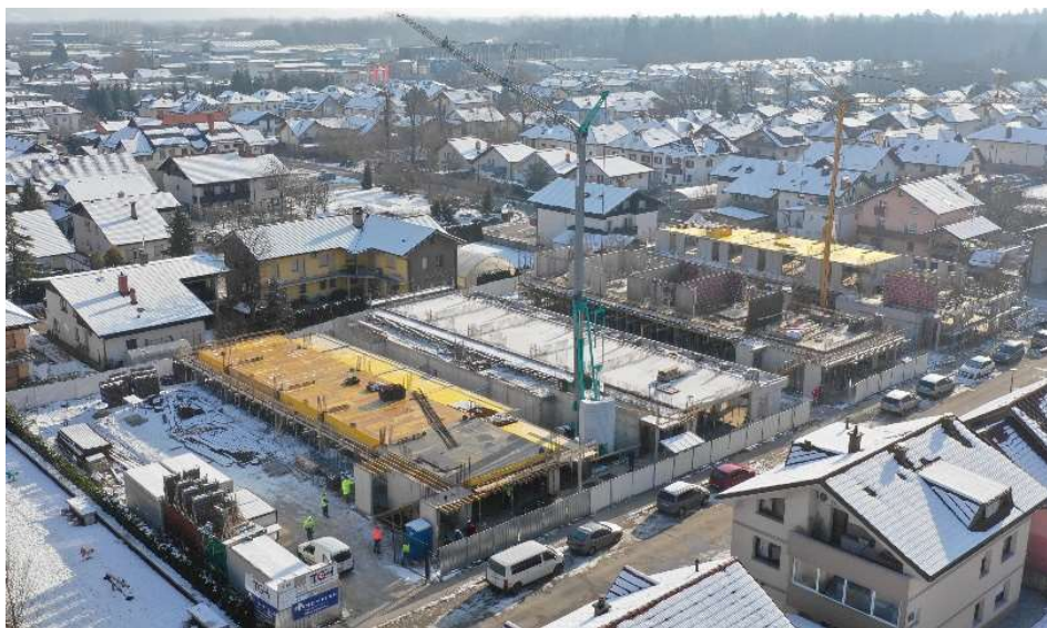
(Ljubljana – Dolgi most, gradnja)
