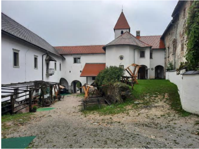
Slika 4: Zahodni in južni trakt z dvoriščem (vir: konservatorski načrt)
