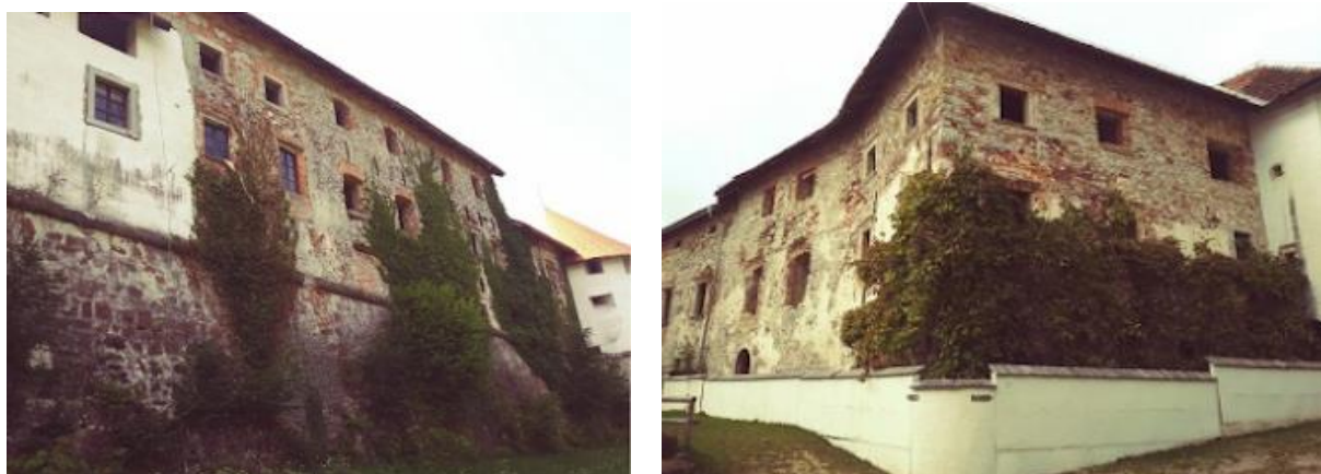
Slika 2: Severni trakt (vir: Konservatorski načrt)
