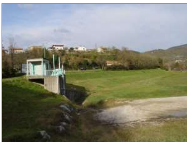
Slika 211. Prikaz protipoplavnega ukrepa – suhi zadrževalnik Pikolud.
